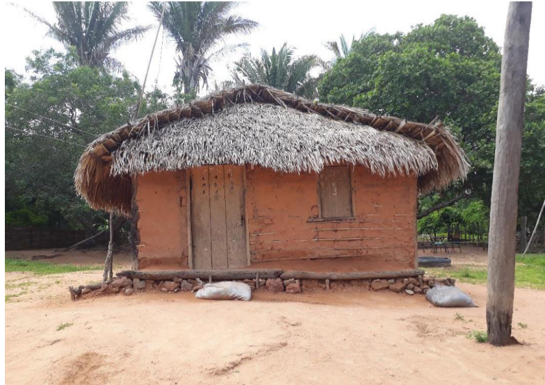
Figura 6 – Casa de taipa sem revestimento
