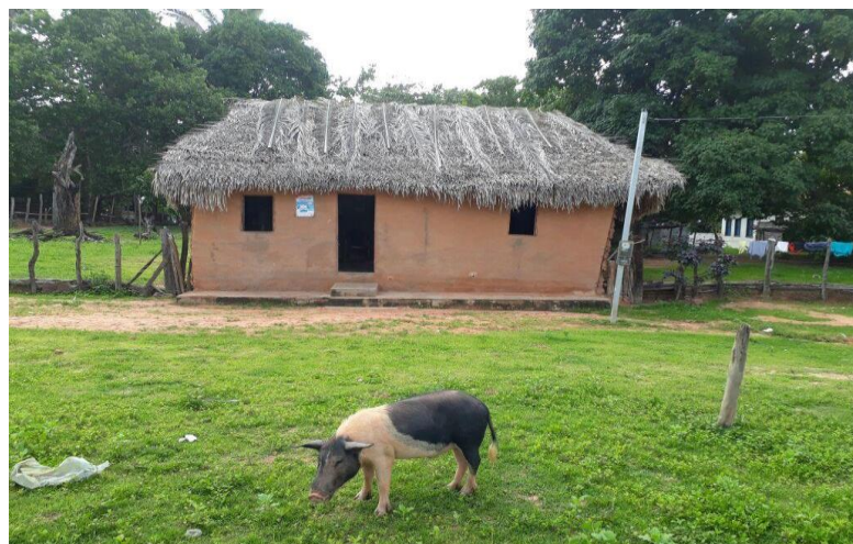
Figura 5 - Casa de taipa com revestimento
