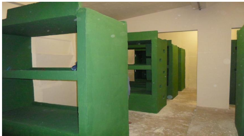
Figura 01- Celas construídas – Projeto Alojamento 5.000
